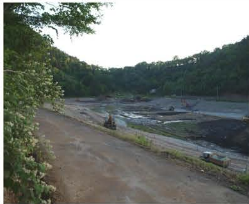
愛宕沼の改修工事
